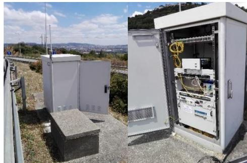
**Fig. 6. Exemplo de instalação num armário de beira da estrada**
